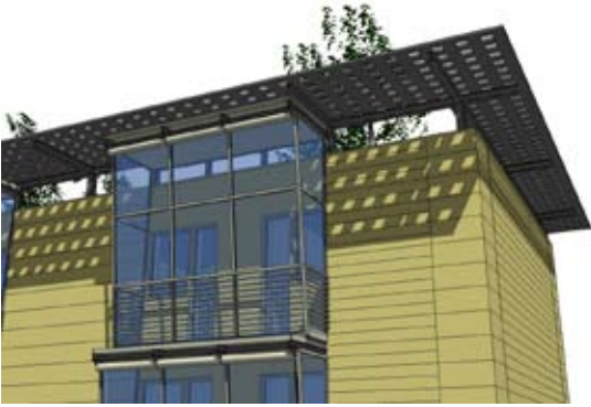
Fig. 1 - Dettaglio della pensilina aggettante
